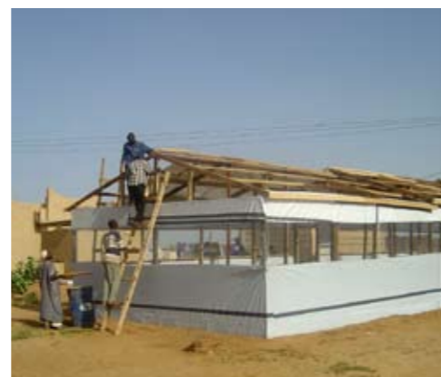
Opførelse af en intensivafdeling - pressening, fluenet og bølgeblik
